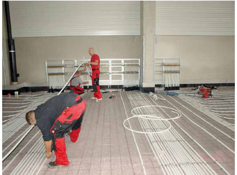
Rohrverlegung im neuen Logistikzentrum von Kuehne+Nagel in Duisburg-Rheinhausen
