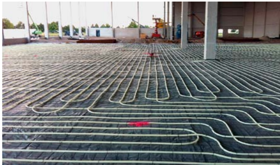
Neubau einer Lagerhalle für Tiefkühlkost in Großkugel (bei Halle an der Saale) mit Kreilac-Unterfrierschutz
